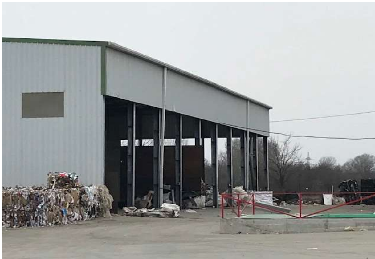
Figura 2-3: Poze stația de sortare
